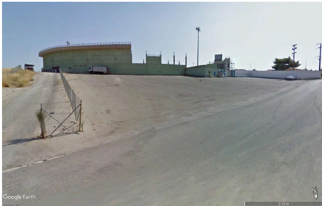
Εικόνα 45: Δημοτικό Στάδιο Φυλής (Υπόβαθρο Google Street)
